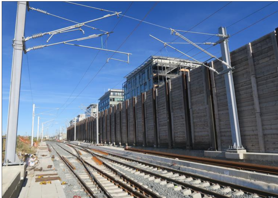
Partie intégrante du RER franco-valdo Genevois en construction, la liaison Ceva est l'emblème des grands projets de mobilité du territoire genevois. Il est rare que dans une agglomération de moins de 100 000 habitants se construisent à la fois un RER et un tramway. Archives photo Le DL/V.B-G.
